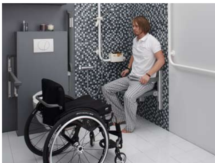
Mange støtteanordninger i dusjsonen bidrar til økt egenomsorg.
