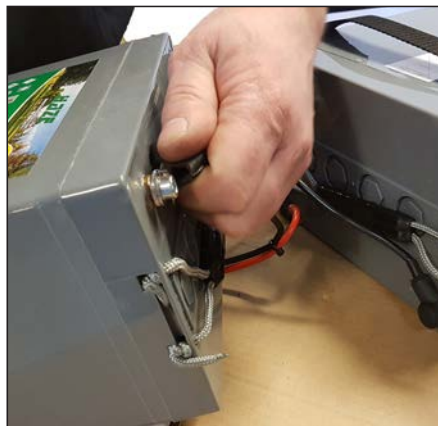
Løsne poleringene på de gamle batteriene og fest på de nye
