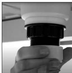
Figur 23 Utskifting av dreneringslange.
