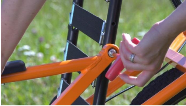
11- Fest armene til ryggen vha umbrakonøkkel
